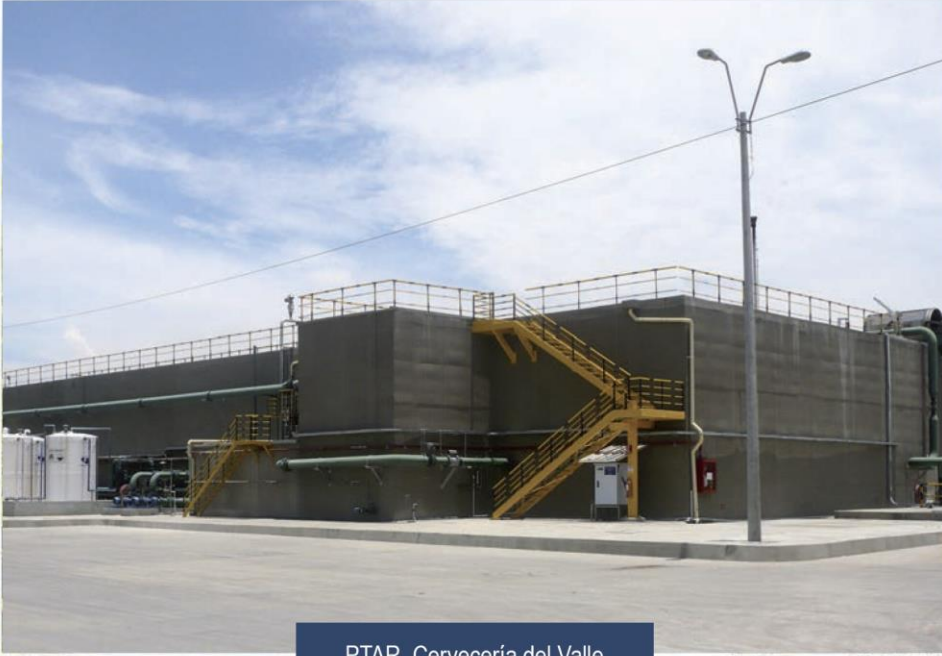
PTAR Cervecería del Valle
