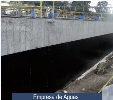
Impermeabilización cimentación
